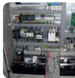
Batteries: durée de vie de 10 ans
